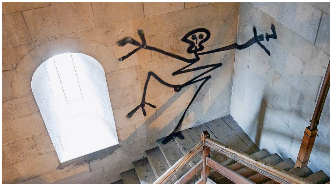
Tanzendes Skelett im nicht zugänglichen Glockenturm. Die Finger der Figur (links im Bild) sprayte Naegeli rund 20 Zentimeter ausserhalb des erlaubten Perimeters auf den unbehandelten Sandstein.
