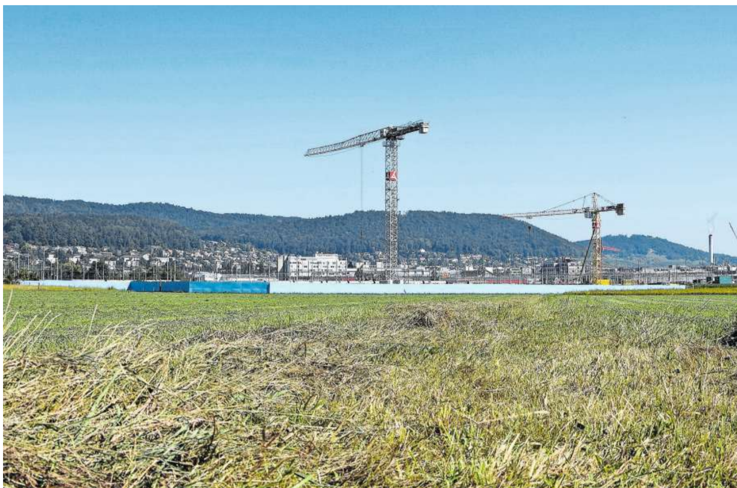
Das Limmattalbahn-Depot entsteht auf einer Fruchtfolgefleiche: Das verbleibende Ackerland sei gut geschützt, sagt der Stadtrat. Bild: og
