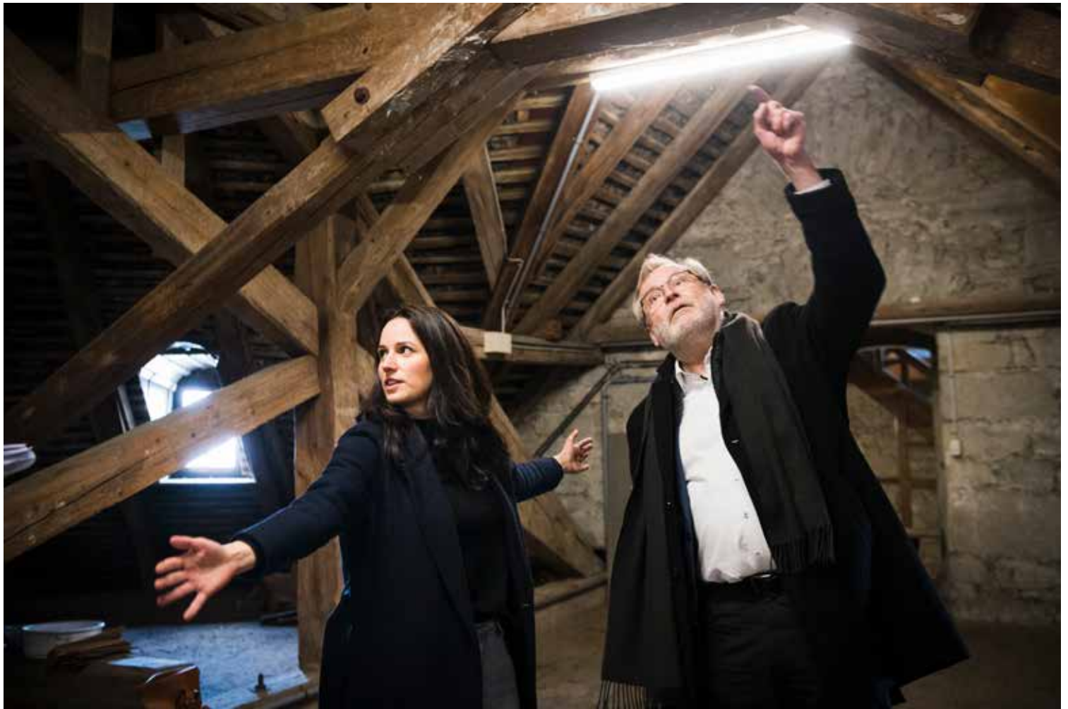
Im Dachstuhl: Christoph Sigrist schaut hoch ins 9,9 Meter hohe Gebälk. Jasmin Schäfer zeigt die Dachlänge an.
